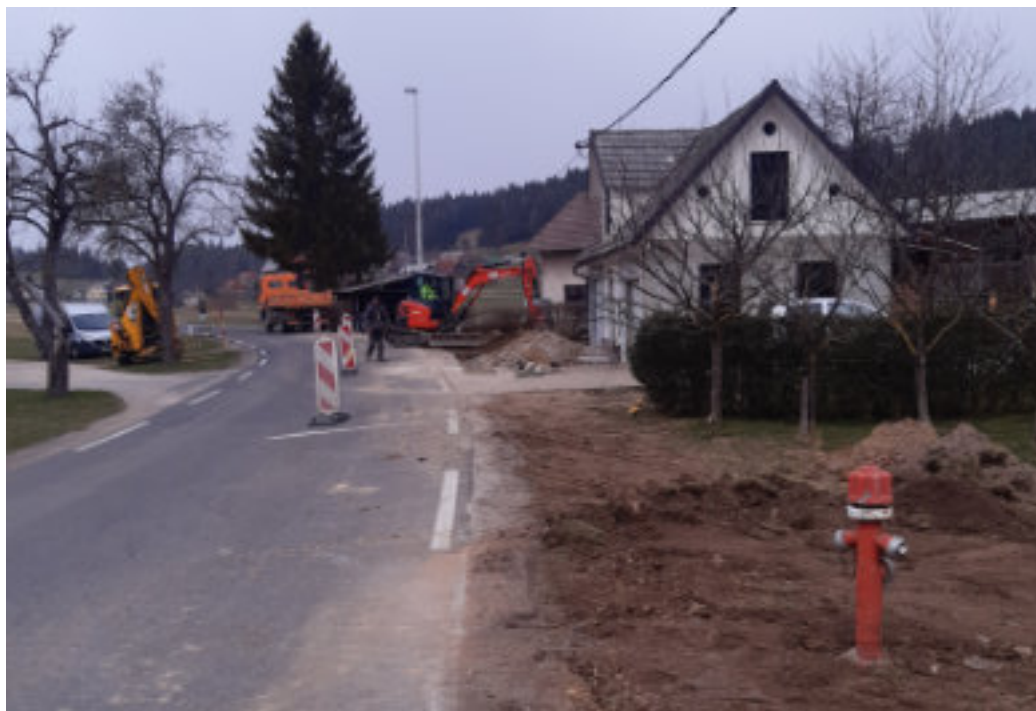
Pravkar obnovljen dotrajani odsek vodovoda proti Nemški vasi
