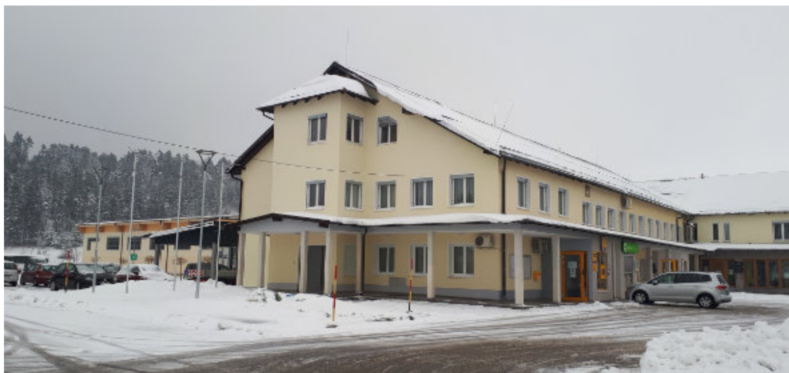
Pogled na dokončno urejen vhod v nove občinske prostore
