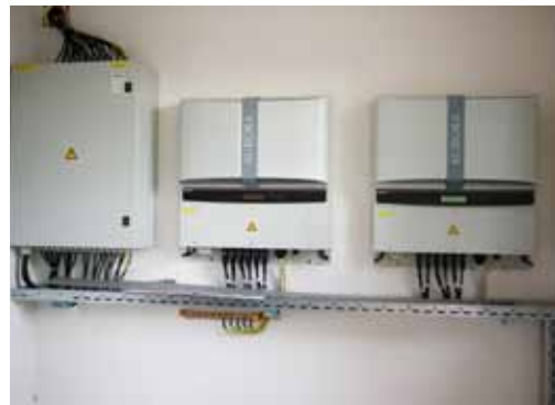
Razsmerniki AURORA 12,5 kW nazivne moči, pretvarjajo enosmerno napetost v izmenično in jo pošiljajo v E. E. omrežje.
