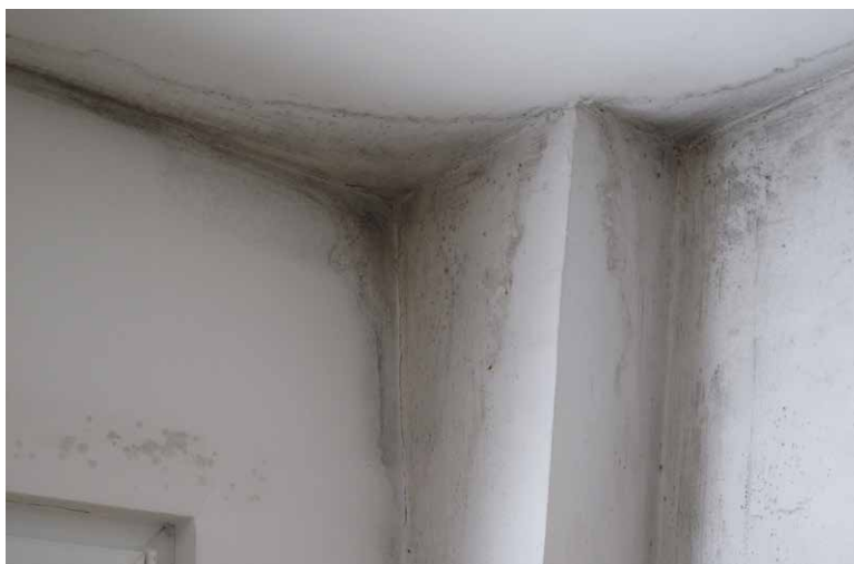
Plesen v sodobno prenovljenem stanovanju je posledica neznanja izvajalcev ali napačne odločitve investitorja zaradi neusklajene izolativnosti ter pomanjkanja prezračevanja.
