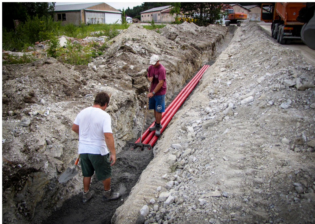
Izgradnja cevne kanalizacije, v kateri bodo nameščeni kabli za elektrooomrežje celotne cone.
